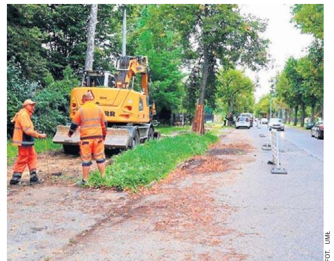
Drogowcy wymienią asfalt i wyremontują chodniki.
