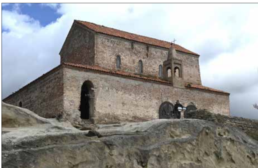
Cerkiew wzniesiona na szczycie kompleksu nazywana jest często „Pańską Twierdzą”. To jedyny w pełni zachowany budynek naziemny w całym skalnym mieście
