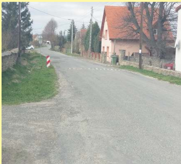
Znamy już wykonawcę dokumentacji na budowę chodników w Górze Sobockiej
