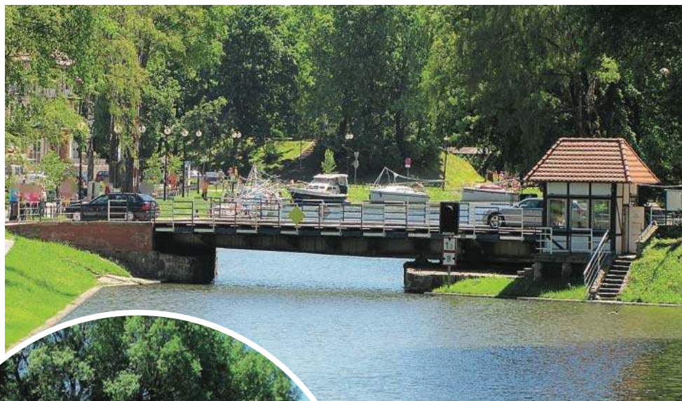
Tak wyglądał most przed remontem
