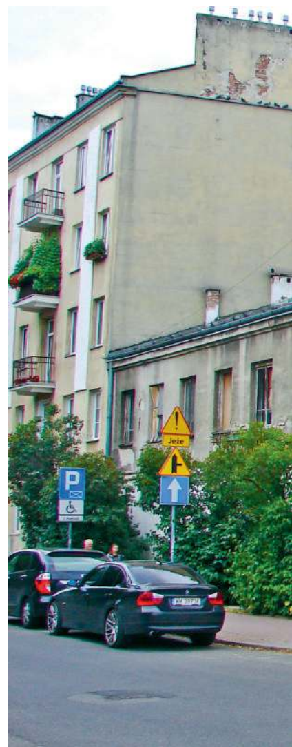
Zabezpieczona kamieniczka Szefflera przy ul. Opaczewskiej
