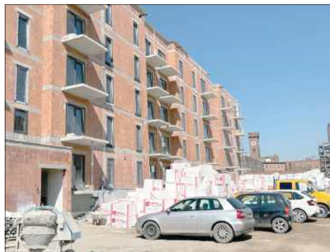
■ Budynek został zaprojektowany jako dwuklatkowy, podpiwniczony, z pięcioma kondygnacjami nadziemnymi
