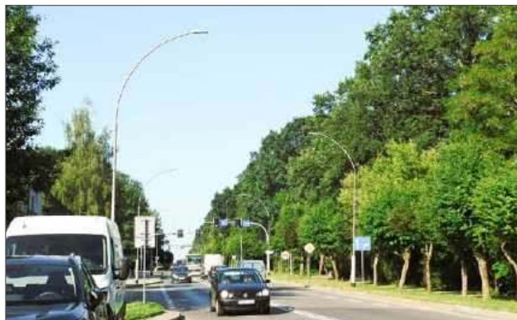
Przy ul. Krakowskiej nowe lampy zostały już zamontowane.
