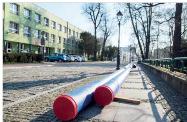
Wymiana instalacji wodociągowej przy „Mechaniku” poprzedza przebudowę ruchliwego skrzyżowania.
