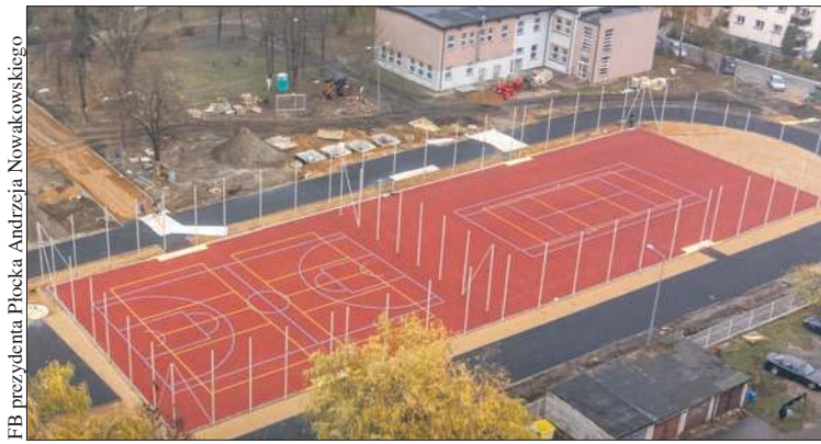
Dobiega końca budowa bazy sportowej przy ZSUiP przy ul. Padlewskiego
