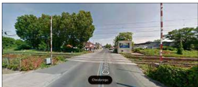
Przejazd ma być zamknięty przez 3 tygodnie.
