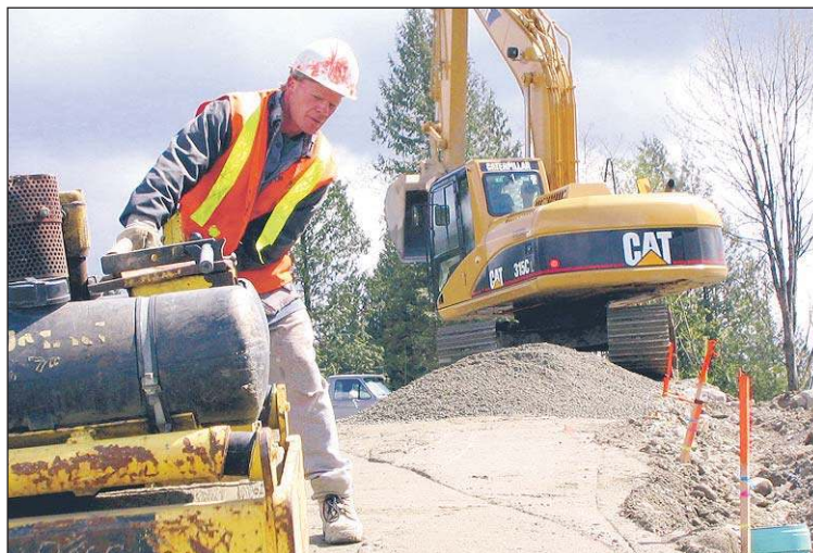
Prace przy drogach powinny zacząć się w październiku. (fot. sxc.hu)
