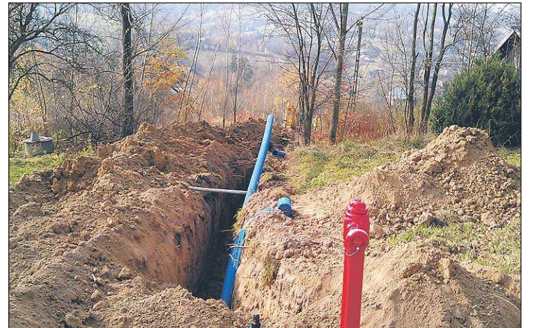
Gminie Dębica dofinansowanie przydałoby się na wykonanie brakujących odcinków kanalizacji w Stasiówce i Stobiernej. (fot. archiwum)
