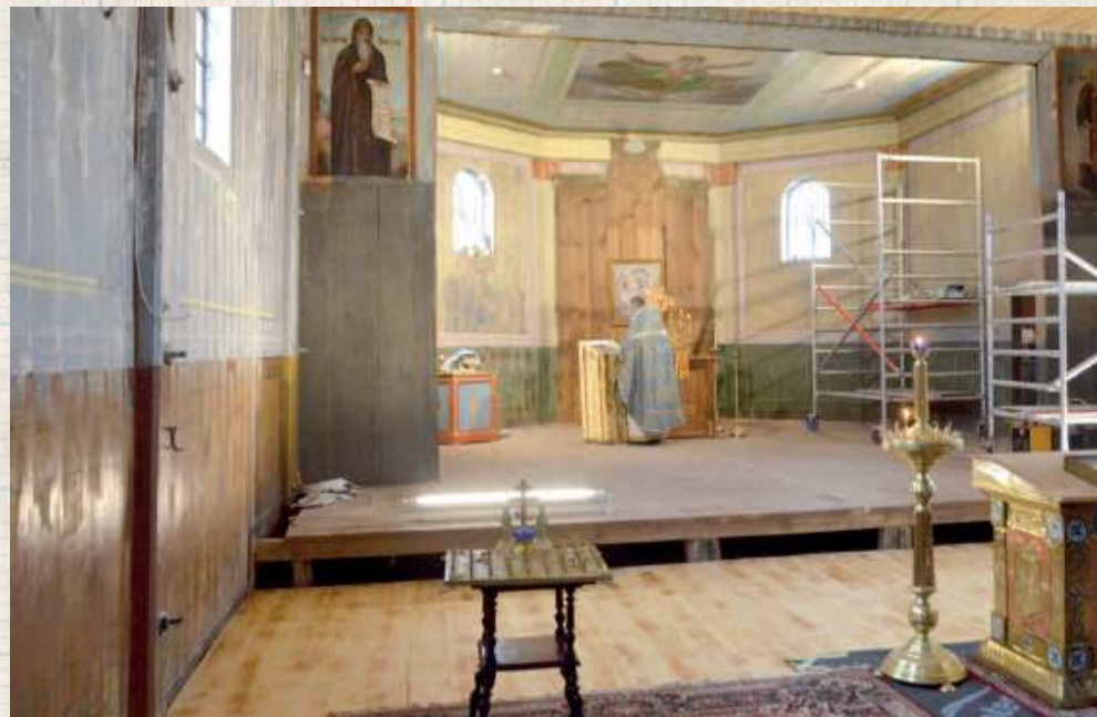
Przez kilkanaście miesięcy remontu wnętrza ksiądz proboszcz Tomasz Łotysz musiał odprawiać bez ikonostasu za to przy rusztowaniach budowlanych. Ale efekt przerósł oczekiwania
