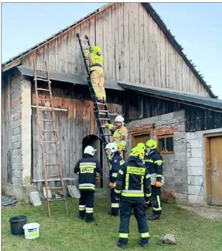
Strażacy z Jażwin i Czarnej zabezpieczali dach. (fot. OSP Jażwiny)
