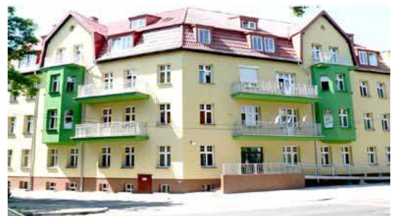
Siedziba Starostwa Powiatowego w Goleniowie - to w tym budynku, na samej górze obraduje rada powiatu
