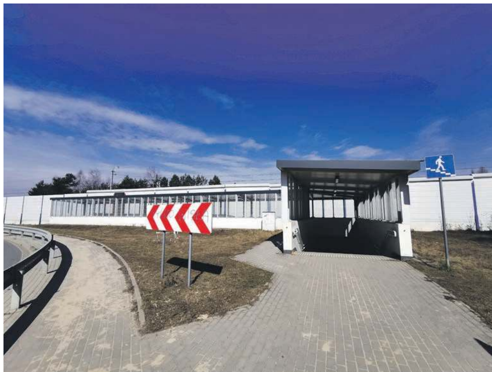
Przejście podziemne w Młoszowej
