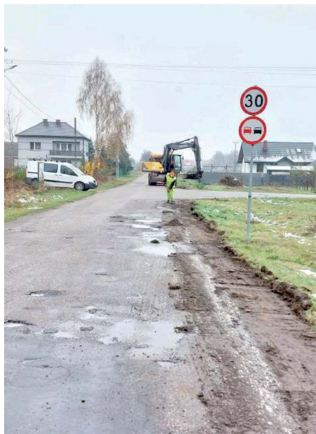
Prace nad kilkoma odcinkami potrwają do końca listopada 2024 r.
