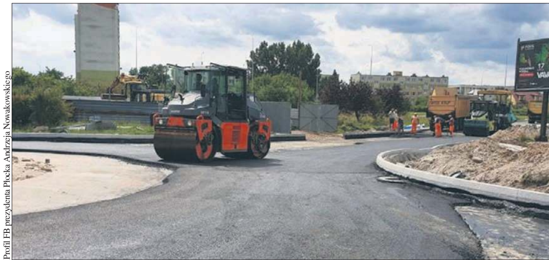
W ubiegłym tygodniu rozpoczęło się układanie asfaltu na skrzyżowaniu ulic Chopina, Lachmana i Spółdzielczej
