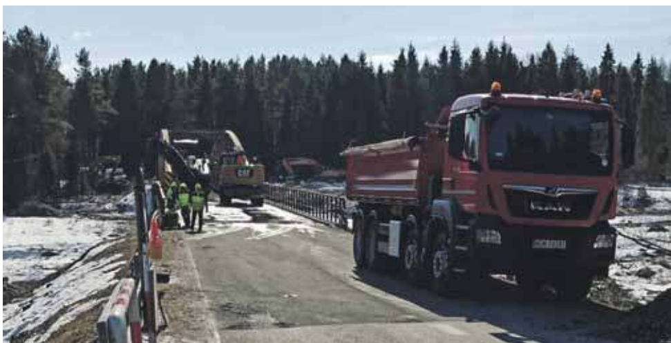
Ruszyły prace rozbiórkowe na moście w Trybszu
