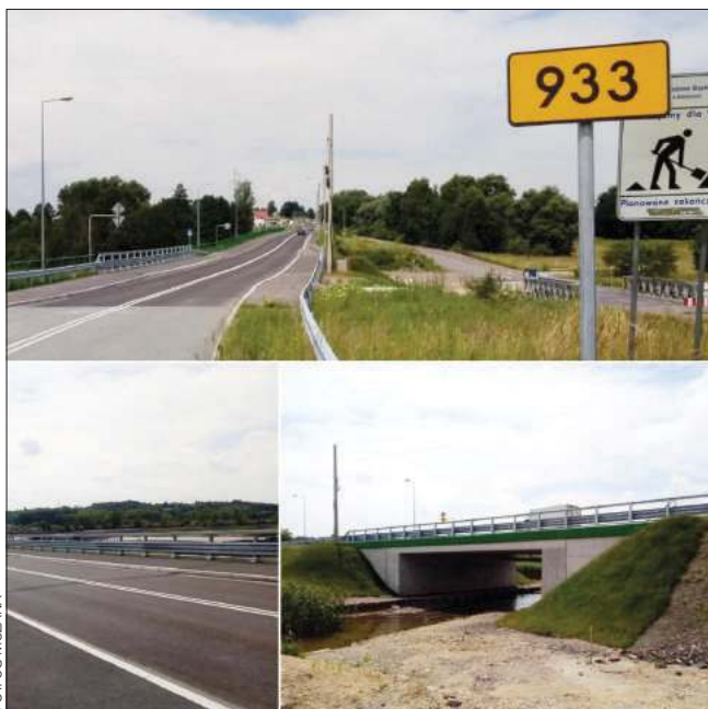
(art) Most na Szotkówce w Mszanie na DW 933 jest już przejezdny
