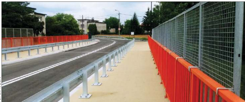
9 czerwca rozpoczęły się czynności odbiorowe, które są zwieńczeniem całej inwestycji. Wiadukt został ostatecznie otwarty 2 lipca tego roku.
