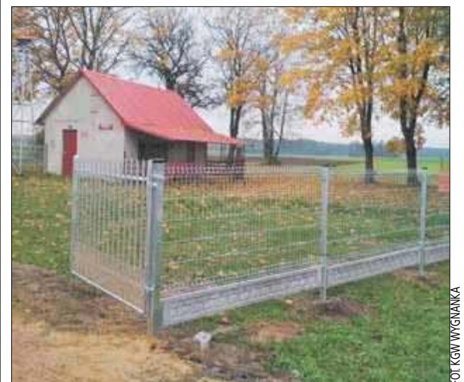
W Wygnance w tym roku ogrodzono świetlicę wiejską. Zamontowano też bramę wjazdową i furtkę. Dokończenie inwestycji zaplanowano na 2021 r. ze środków z funduszu sołeckiego
