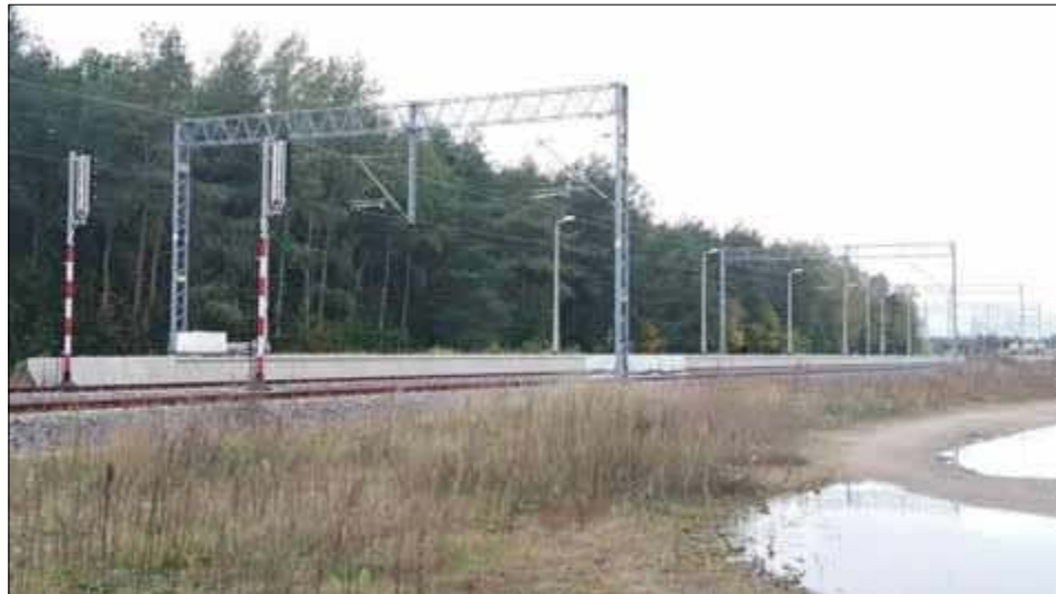
Nowa stacja kolejowa budowana na wysokości os. Biawena będzie nosić nazwę Biała Podlaska Wschodnia
