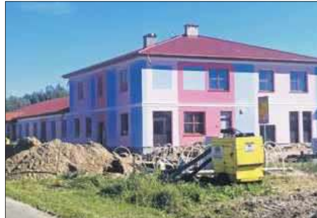
W ramach rewitalizacji w 2021 r. zostanie uruchomiony ZOL w Curyńcu
