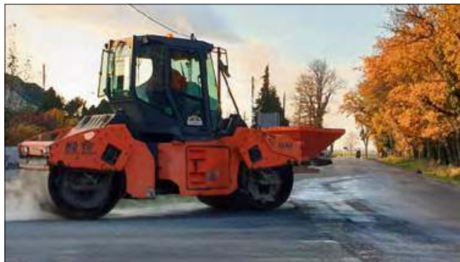
Gmina Zdzieszowice chce sukcesywnie remontować kolejne drogi gminne.
