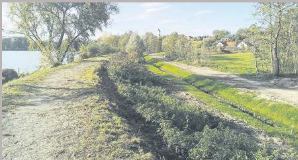
Prace konserwacyjne 500-metrowego odcinka polegały głównie na odmuleniu oraz ścinaniu i karczowaniu gęstych krzaków (Foto. UMiG Strzelin)
