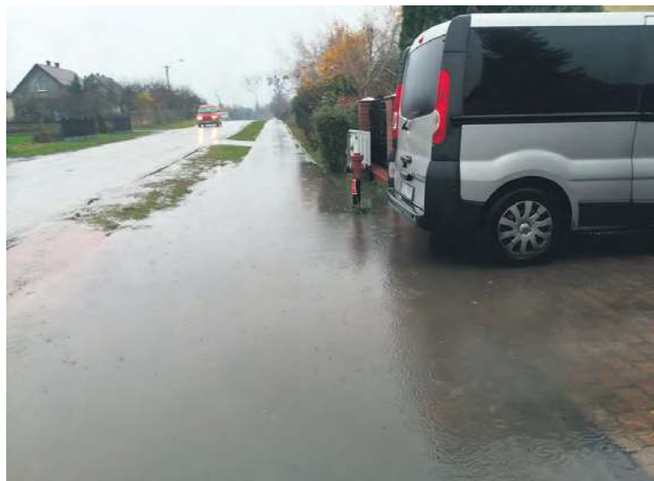
Woda gromadzi się na ścieżce rowerowej, a następnie wdziera na posesję. I tak za każdym razem, kiedy pada deszcz. Fot. nadestane
