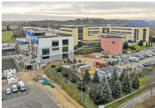
Trwa budowa Centrum Popularyzacji Nauki „Kortosfera”
