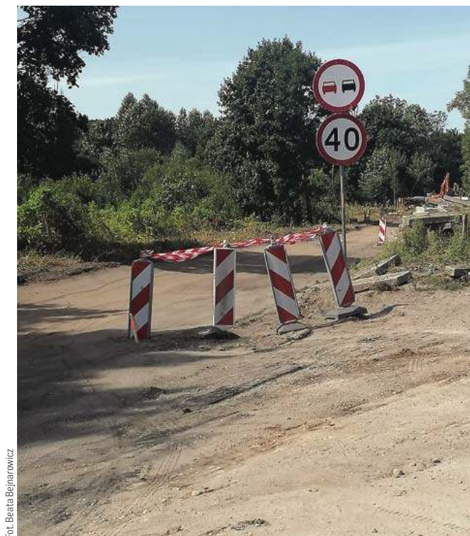
Przebudowa drogi zablokuje dojazd do sklepu
