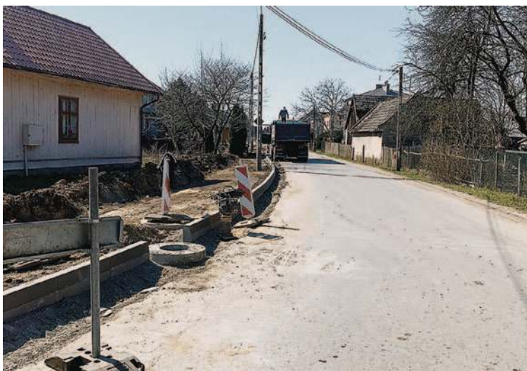
W ramach przebudowy ulicy Sopockiej w Nisku wykonywane są m.in. nowe chodniki
