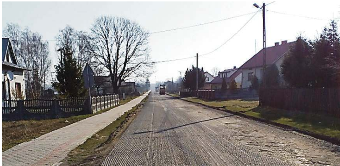
W Hucie Nowej przed Wielkanocą zakończono roboty przygotowawcze, w tym frezowanie nawierzchni
