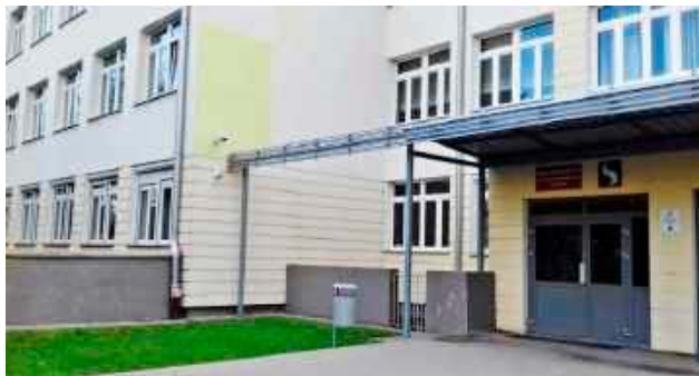
Najwięcej pieniędzy z tegorocznej puli inwestycji oświatowych miasto przeznaczy na prace przy i w SP nr 5
