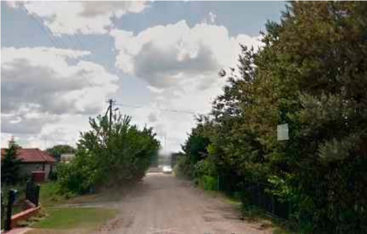
Jeszcze w tym roku gruntowa dziś ulica Drewniana zyska nawierzchnię z kostki brukowej
