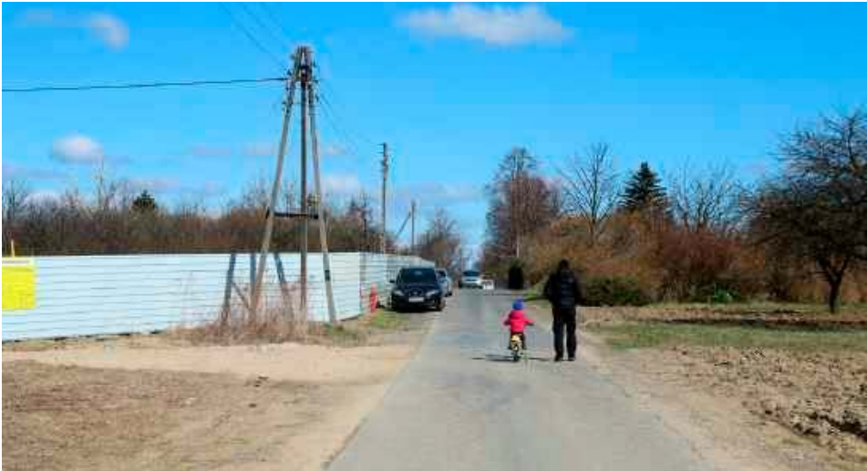
Mieszkańcy Ponikwody skarżą się, że ciężarówki dowożące materiały na prowadzoną przez dewelopera budowę przy ul. Narcyzowej, niszczą niedawno wyremontowane osiedlowe ulice, do naprawy których sami się dokładali. I pytają kto za to zapłaci?
