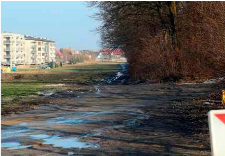
Przetarg na wykonanie ostatniego odcinka al. NSZZ „Solidarność” zostanie powtórzony
