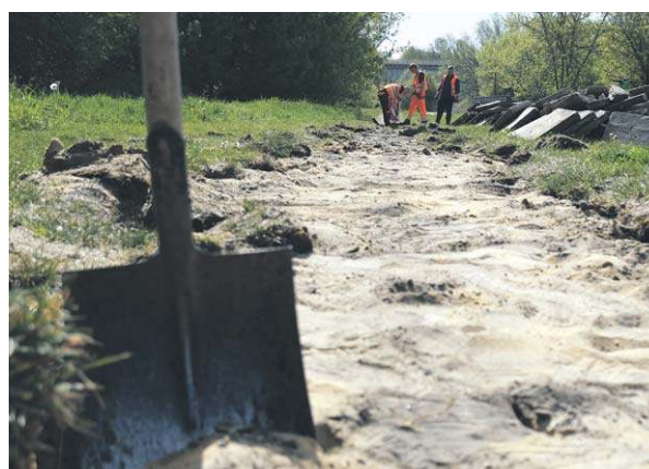
Prace przy remoncie ul. Janowskiej rozpoczęły się
