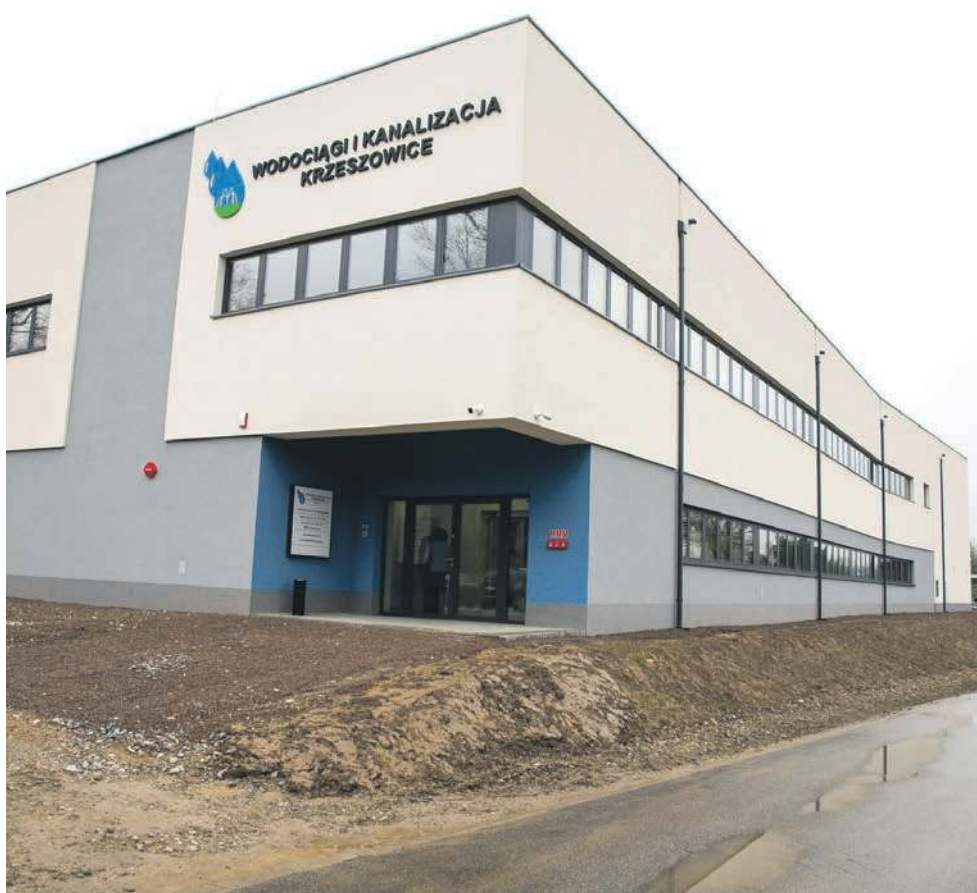
(e) Nowa siedziba przy ul. Czycza w Krzeszowicach, nieopodal oczyszczalni ścieków
