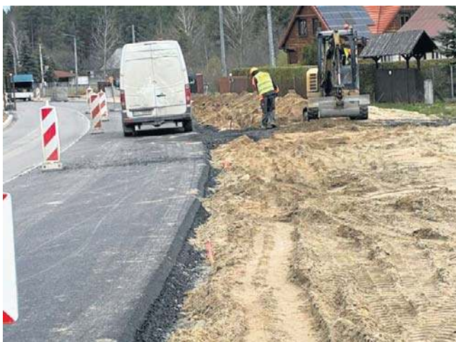
Prace prowadzone są na całym odcinku drogi
