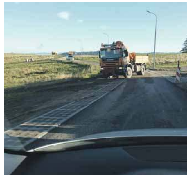
Ciężarówka jeździ na prywatną posesję w czasie trwającego remontu nawierzchni.
