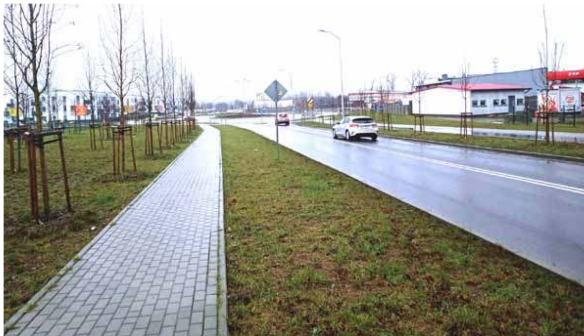
Gotowy odcinek obwodnicy północnej miasta między ulicami Składową a Orzeszkowej
