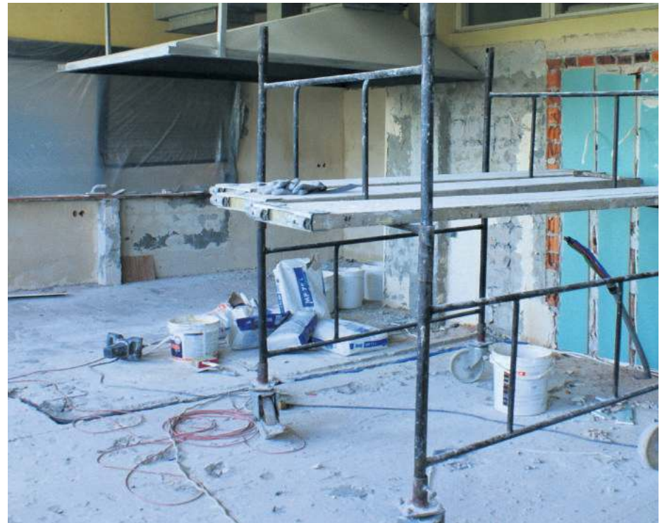
W szkolnej kuchni w Borowie trwa gruntowny remont
