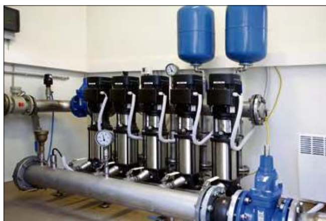
Plada Sp. z o.o. inwestuje w nowoczesną infrastrukturę wod-kan.
