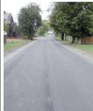
Przebudowana droga Wola Chomejowa - Brondzin
