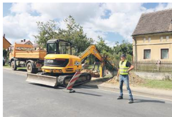
W Jegłowej prowadzone są równolegle dwie inwestycje – budowa sieci kanalizacji sanitarnej wraz z oczyszczalnią ścieków oraz przebudowa sieci wodociągowej
