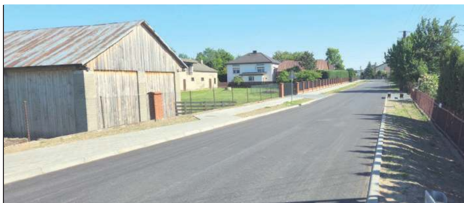
Poza mostem przebudowana została również droga gminna nr G101522L
