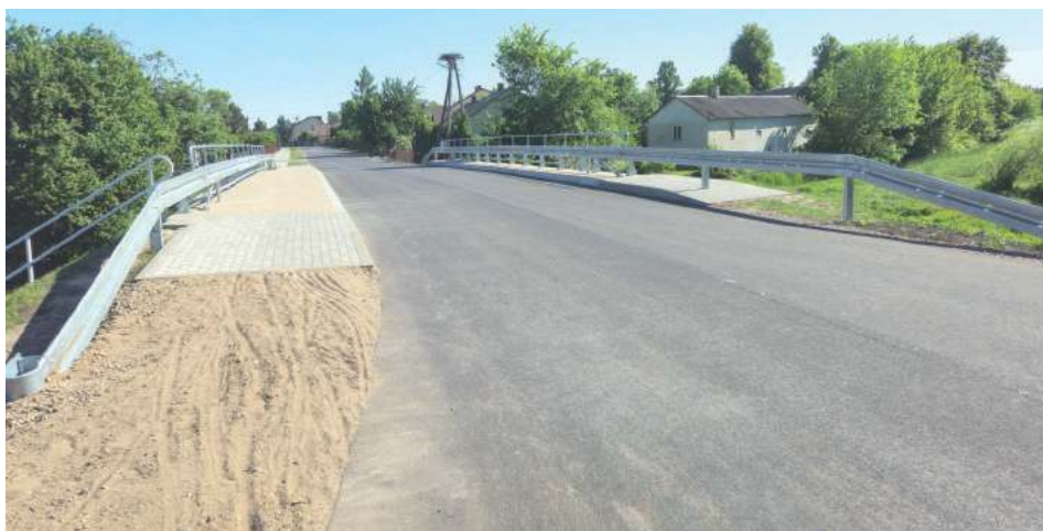
Nowy most zostanie wybudowany również przy drodze nr G101476L w miejscowościach Misie i Przychody
