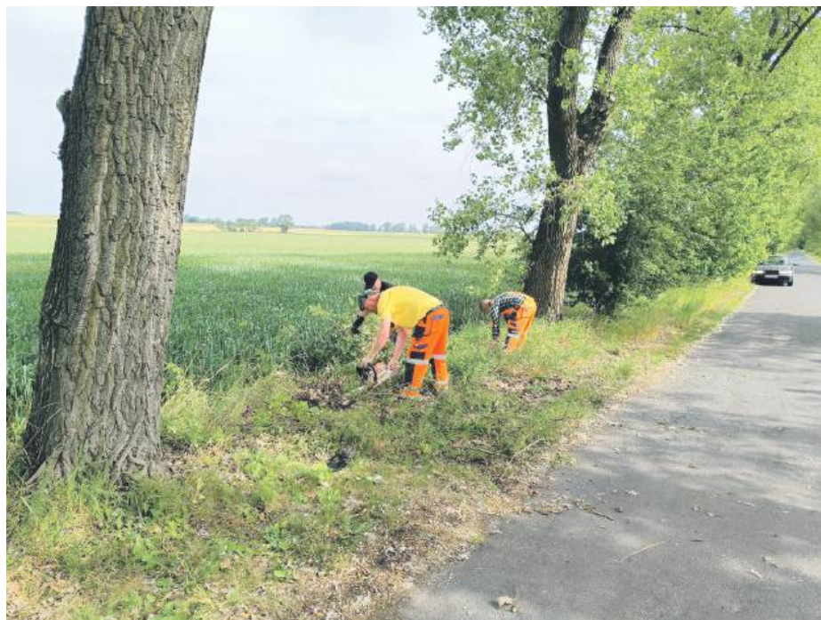
Pracownicy PZD w trakcie odkrzaczania pobocza. Na dalszym planie widać jak pas przy drodze wyglądał przed tymi pracami
