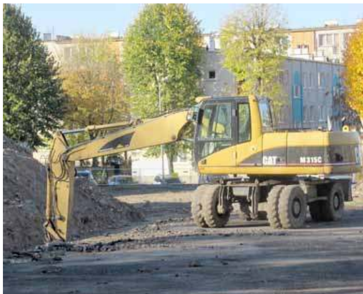
Początek budowy hali - 31.01.2018
