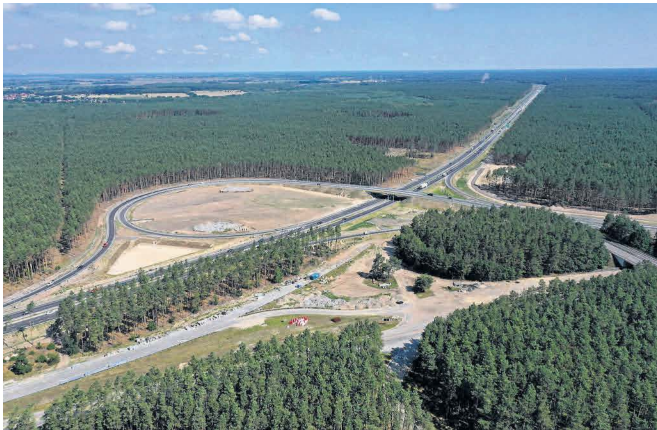
Węzeł Rzęśnia. Trwają prace wykończeniowe, które powinny być sfinalizowane w kwietniu bieżącego roku
