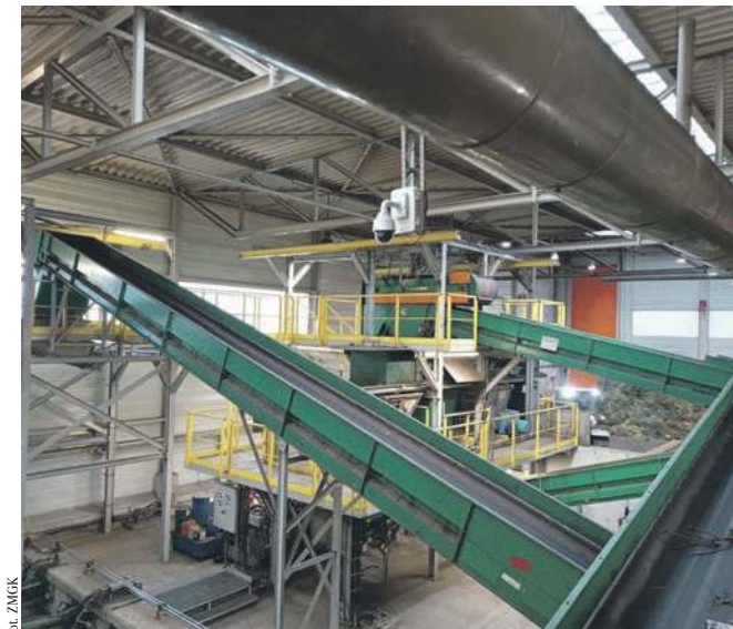
W środku biogazowni
