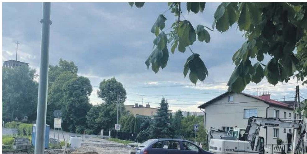
Prace przy przebudowie skrzyżowania ul. Piłsudskiego i Kościelnej w Trzebinii rozpoczęły się w pierwszych dniach marca tego roku
