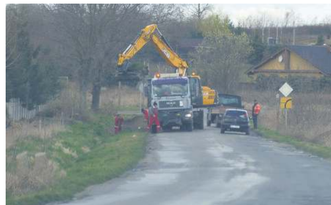
Po pracach związanych z odwodnieniem jezdni (czyszczeniem rowów i przepustów) już za kilka dni na tym odcinku mają rozpocząć się roboty drogowe
