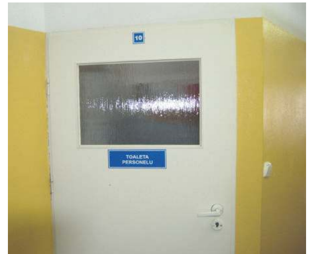
Póki co łazienka dla osób niepełnosprawnych znajduje się w toalecie dla personelu. Podczas wakacji pomieszczenie ma zostać wyremontowane, tak aby w pełni je dostosować
