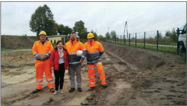
Współpraca z pracownikami Budimexu układała się wspaniale. Panowie pomogli uratować świetlicę przed możliwym zalewaniem po większych opadach deszczu
