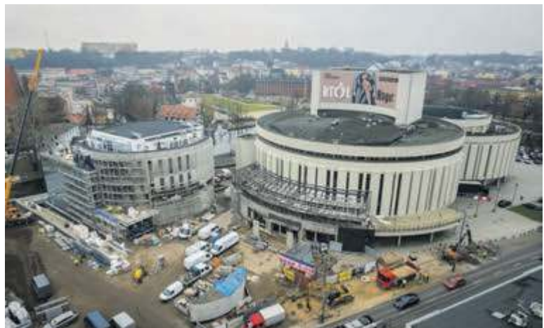
Budowa czwartego kręgu Opery Nova w Bydgoszczy
