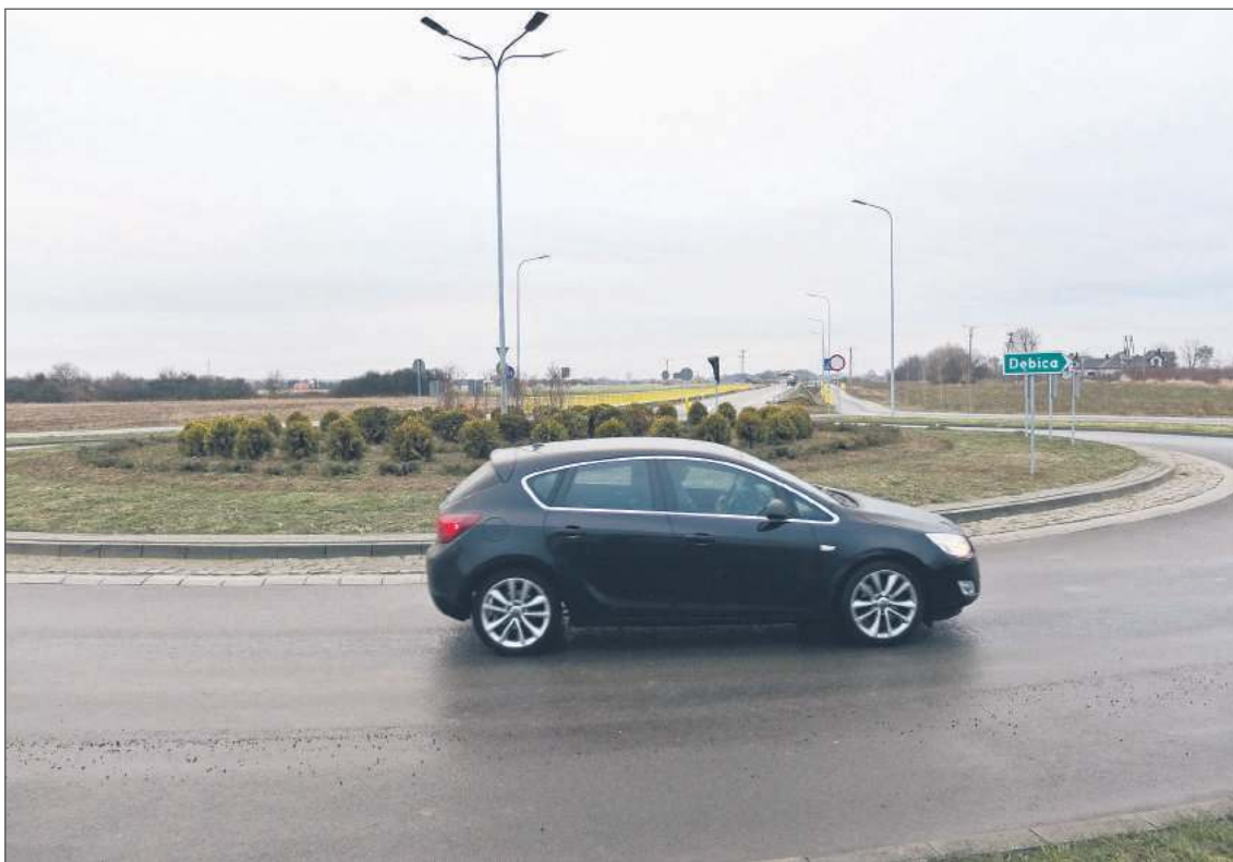
Kierowcy korzystają już z ronda w Straszęcinie, wjazd na łącznik możliwy będzie za kilka dni.
