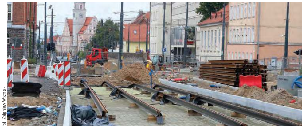
Budowa nowej linii ma zakończyć się w październiku tego roku
