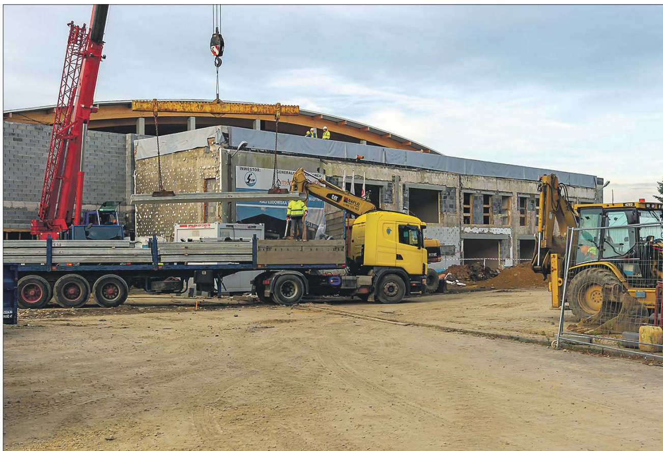
Wciąż na budowie nie brakuje widowiskowych robót
