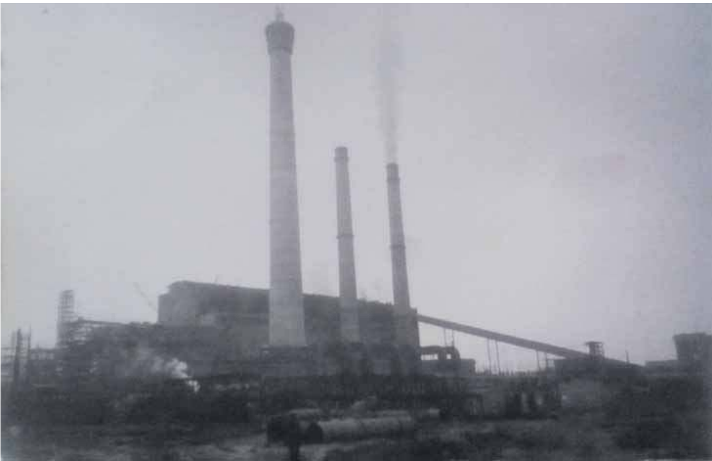
Dawna Elektrownia Jaworzno II, czyli jaworznicka siłownia (MMJ)
