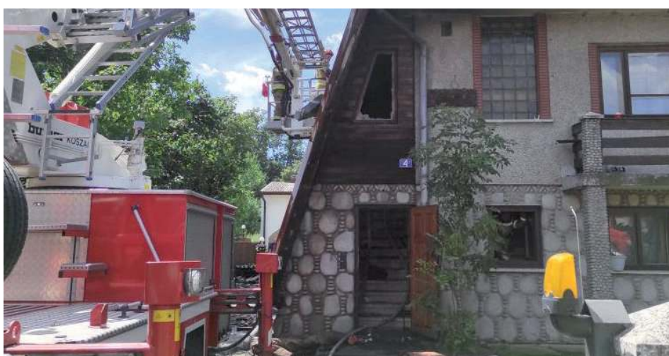
Spaleniu uległa klatka schodowa z wyposażeniem, częściowo korytarz na pierwszym piętrze
