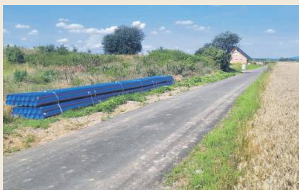
Wodociąg wybudowany zostanie do nowo powstałych działek budowlanych w Karczynie i w Kondratowicach. Fot. UG Kondratowice
