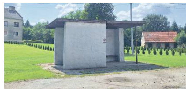
W planach jest pomalowanie przystanku autobusowego
